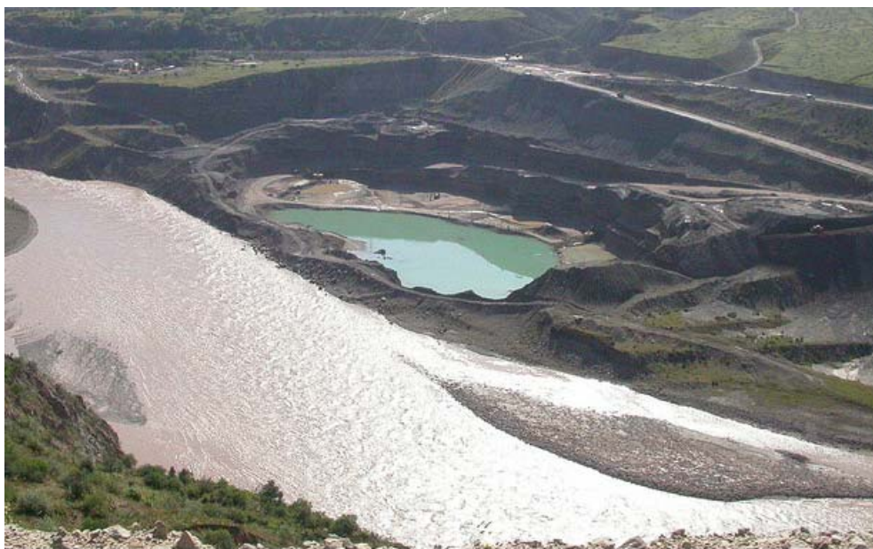
Слика 36. Депонија од око 14 милиона m^3 каменог материјала за потпорна тела бране "Рогун", лежи низводно од бране [5].
