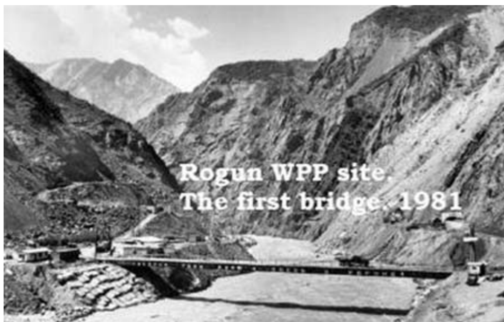
Слика 27. Снимак је начињен 1981. године. На њему се види први изграђени мост преко реке Вахш ради превозења материјала из тунела и почетка радова на бетонирању облоге тунела бране "Рогун" [5].
