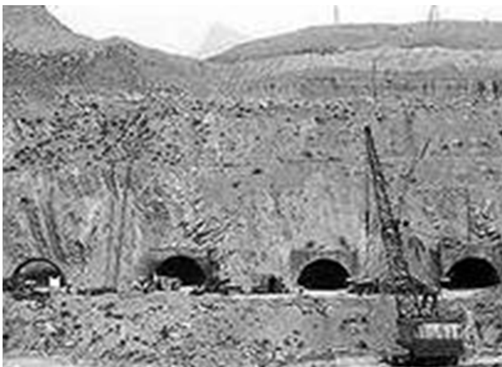
Слика 38. Снимљена је у току грађења улазних грађевина за подземну хидроелектрану. Не виде се још две улазне грађевине [18].
