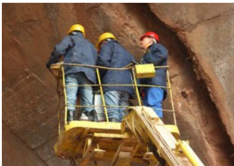
Слика 53. Санација излазне грађевине оптичног тунела ОТ2. Скоро при врху попречног пресека тунела, налазе се радници, који треба да измалтеришу спојницу и изглачају је до "црног сјаја". Видети слику 52 [19].
