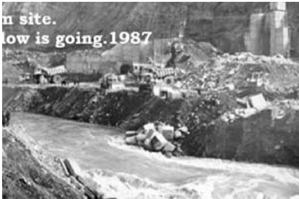
Слика 39. Снимак је начињен 27. децембра 1987. године. На њему се види како са леве и десне обале почиње преграђивање реке Вахш ради грађења узводне предбране, која ће бити део главне бране "Рогун" [5].
