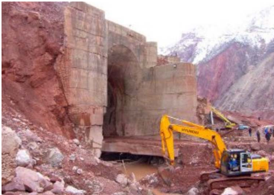
Слика 51. Уклањање материјала који се сручио са падине брда изнад тунела на улаз једног од транспортних тунела у току поплаве која се догодила 1993. године. Надошла река Вахш је провалила предбрану и поплазни телас је однео све испред улаза и вода је плавила тунел [19].
