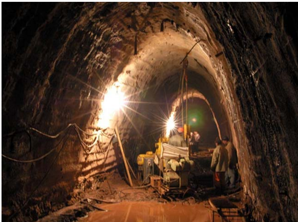
Слика 30. Део завршеног тунела за одвођење каблова из подземне трансформаторске сале [16].
