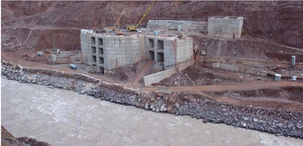
Слика 29. Будући портали - улази у опточне тунеле ОТ1 (лево) и ОТ2 (десно), на почетку грађења, код камено-земљане бране "Рогун" (Интернет: The Rogun Dam Project As Seen Through Uzbek Eyes).
