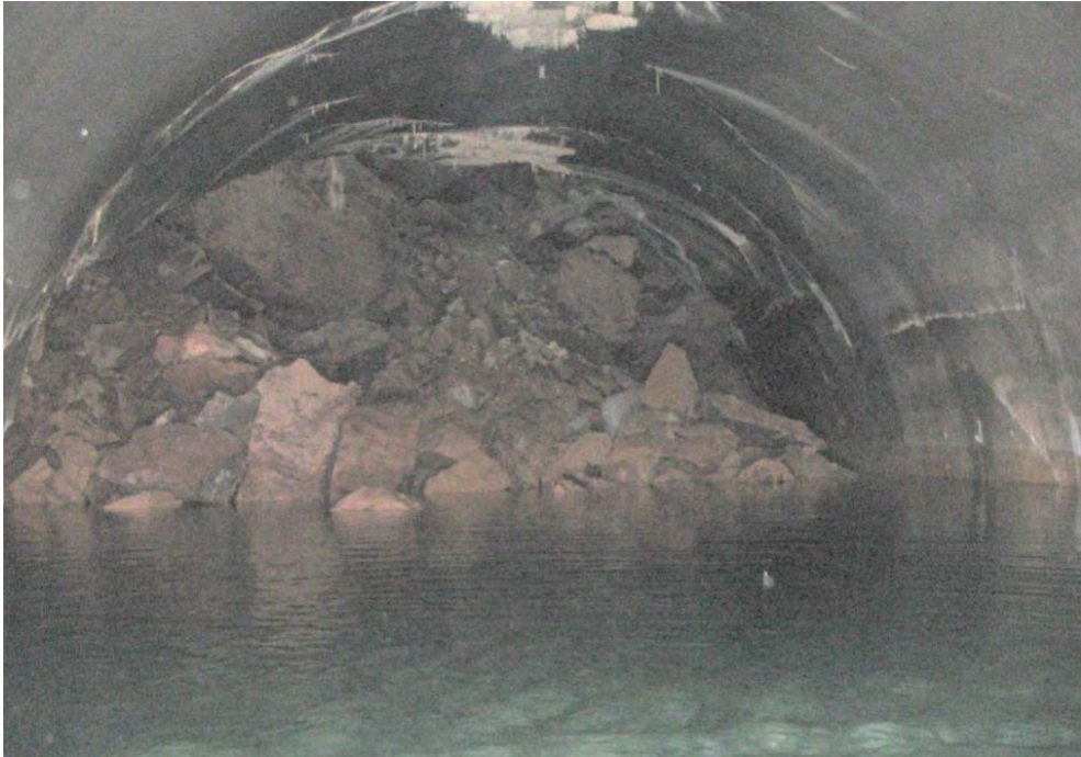
Слика 45. Киша која је непрекидно падала два дана, и сливала се низ стрме падине изнад портала оптичних тунела ОТ1 и ОТ2, покренула је и веће комаде стена, које су "бомбардовале" и пробиле облогу тунела, а портале бациле у воду, запуњавајући тунеле камењем [14].
