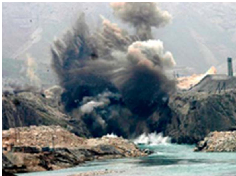
Слика 54. Минирање огромних стена које су се у току поплаве из 1993. године скотрљале у реку Вахш, на почетку наставка грађења бране "Рогун" децембра 2006. године (фото Reuters/Nozim Kalandarov, Tajikistan).
