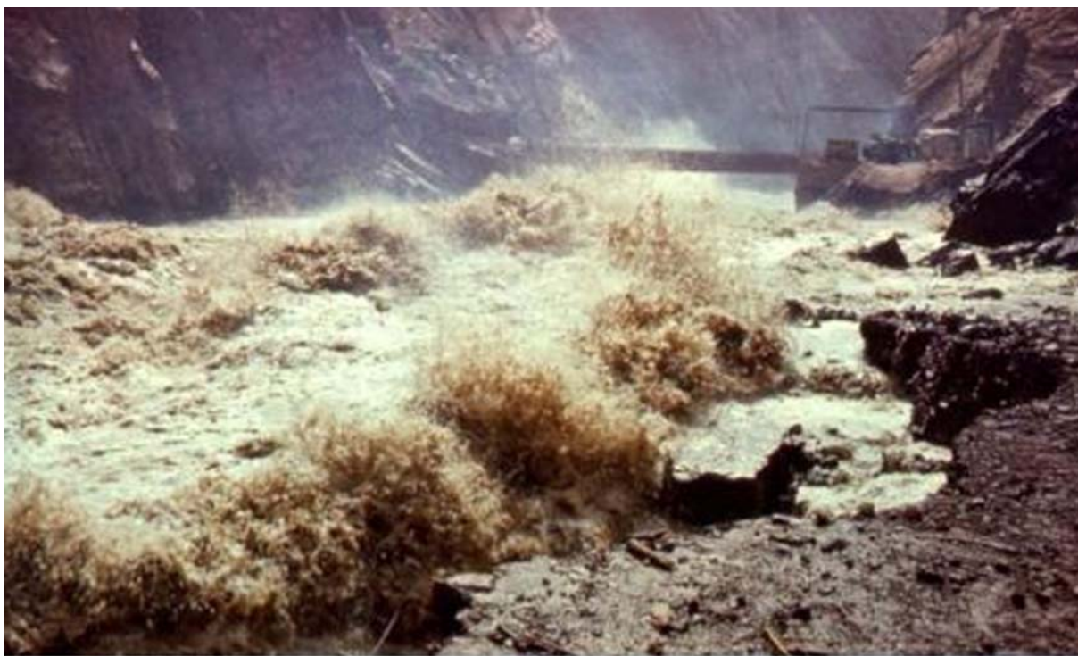
Слика 43. Снимак је начињен неколико десетина минута пошто је вода преплавила предбрану и однела материјал од кога је била направљена [5].
