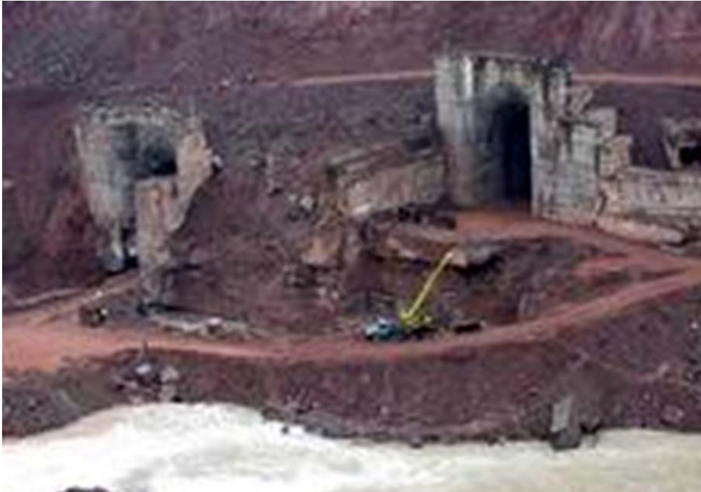
Слика 28. Улази у опточне тунеле ОТ1 (лево) и ОТ2 (десно), на почетку грађења, код камено-земљане бране "Рогун" (Интернет: "Rogun" Hydropower Project, Tajikistan).
