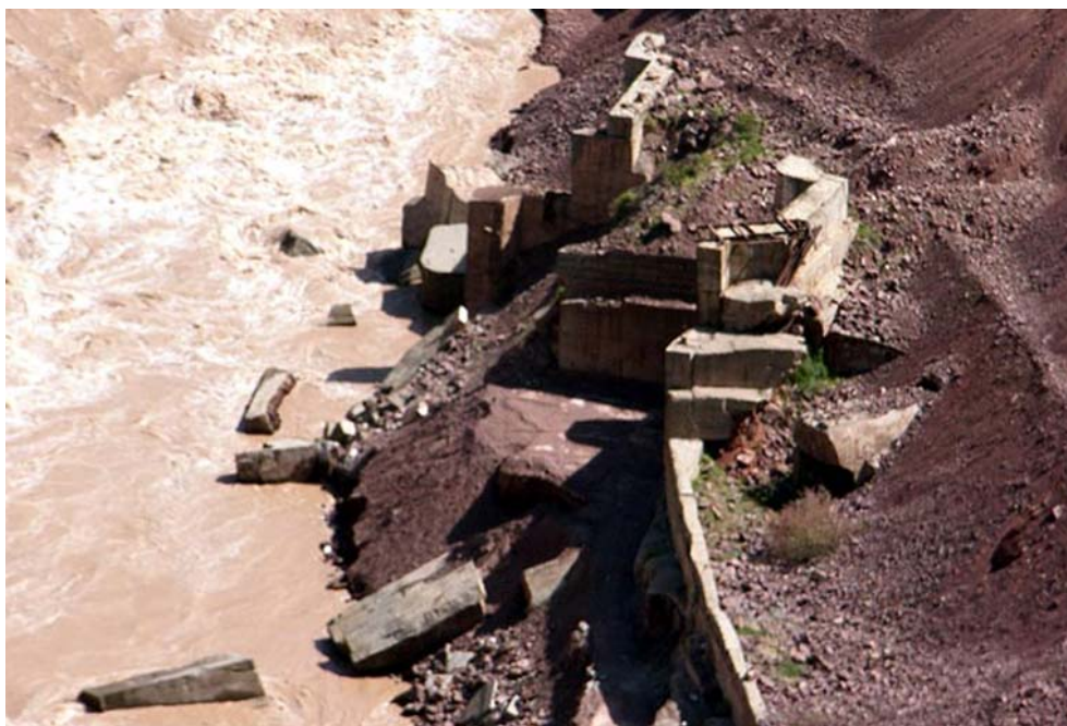
Слика 44. Вода која се сливала низ падину планине покренула је и веће комаде стена, које су слично бомбама, падале на портале оптичних тунела ОТ1 и ОТ2, пробијале бетон и запуњавале тунеле камењем [14].
