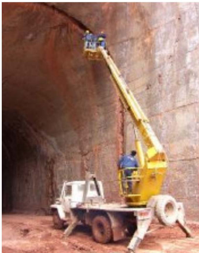
Слика 52. Санација излазне грађевине оптичног тунела ОТ2. Дизалица је подигла раднике скоро до врха калоте тунела да би спојницу измалтерисали и изглачали до "црног сјаја". Видети и слику 53 [19].
