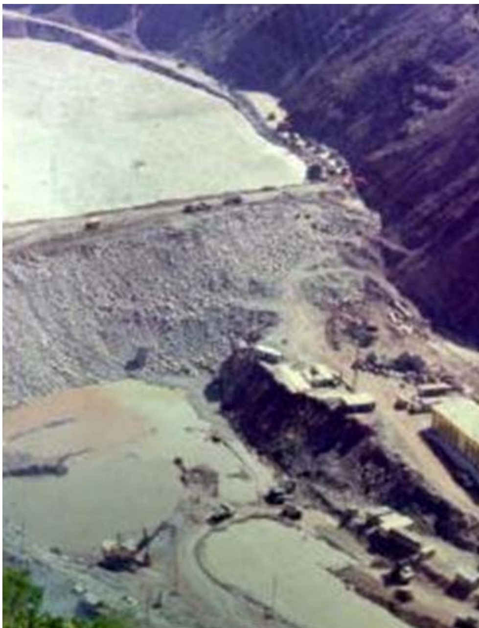
Слика 40. Предбрана је већ 1990. године достигла висину од 40 m (треба да буде висока 100 m). Предбрана је скренула реку Вахш у оптични тунел ОТ1 бране "Рогун" [5].
