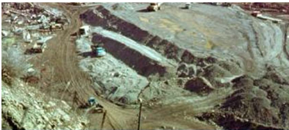
Слика 41. Направљене су 1987. године две низводне бране и предбрана, па је у простору између њих почела обрада и копање за глинено језгро бране "Рогун" [5].
